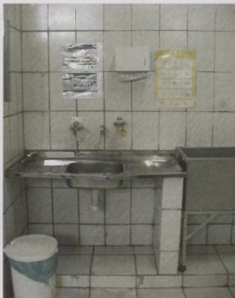
Fig. 8. Detalhe de pia na área de manipulação.
